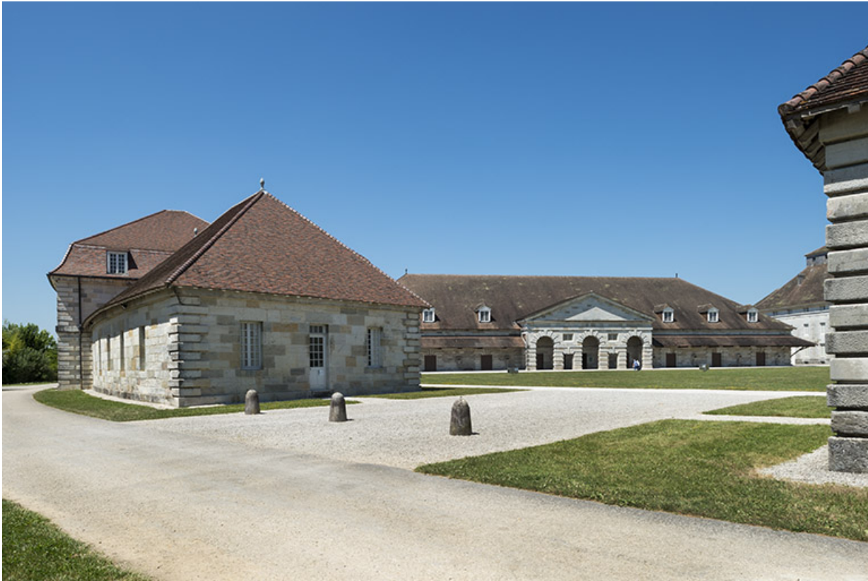
Logement d'ouvriers et berne ouest.
