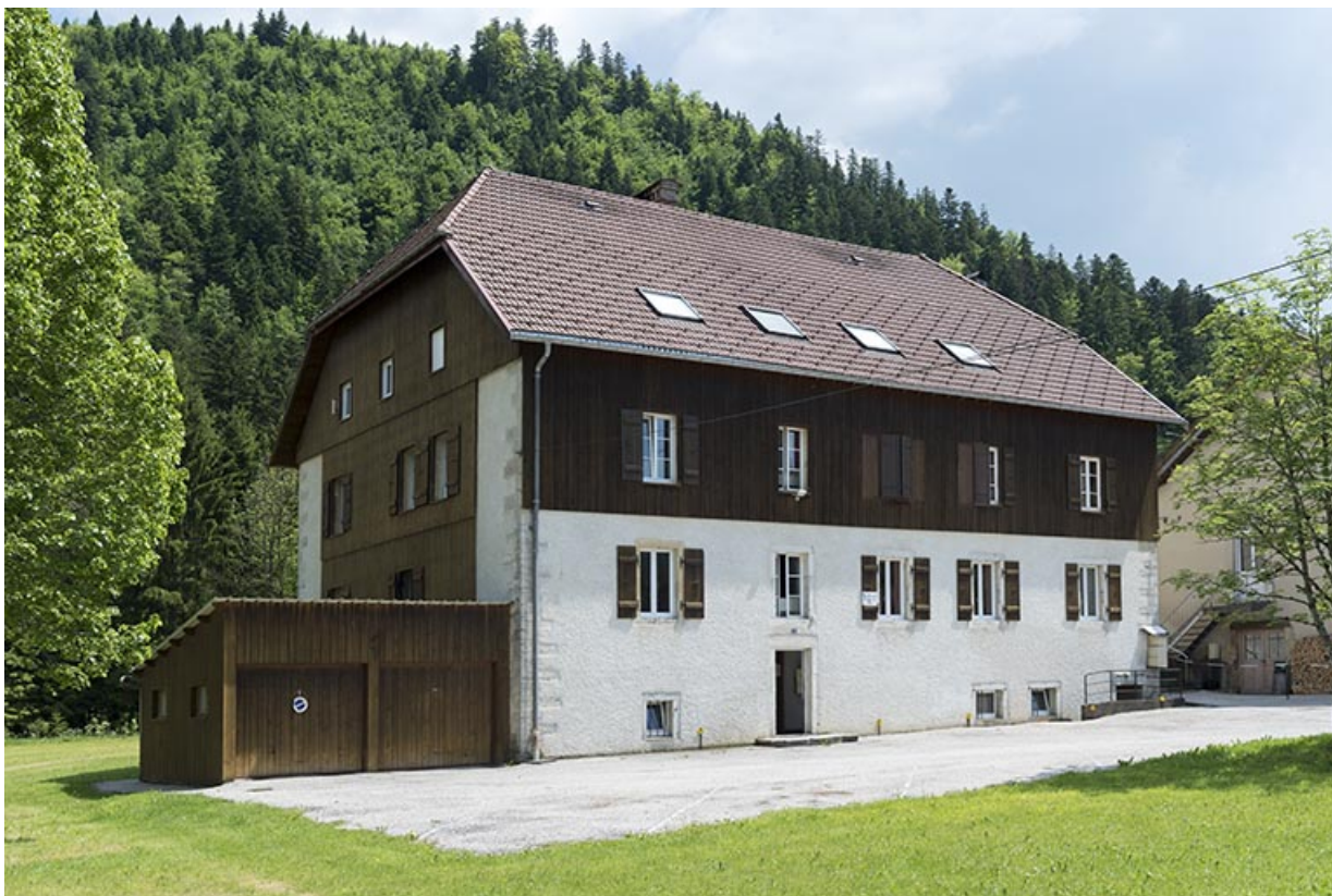
Chaudronnerie : façades antérieure et latérale gauche.
