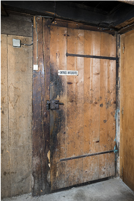
Intérieur : porte de l'atelier.
