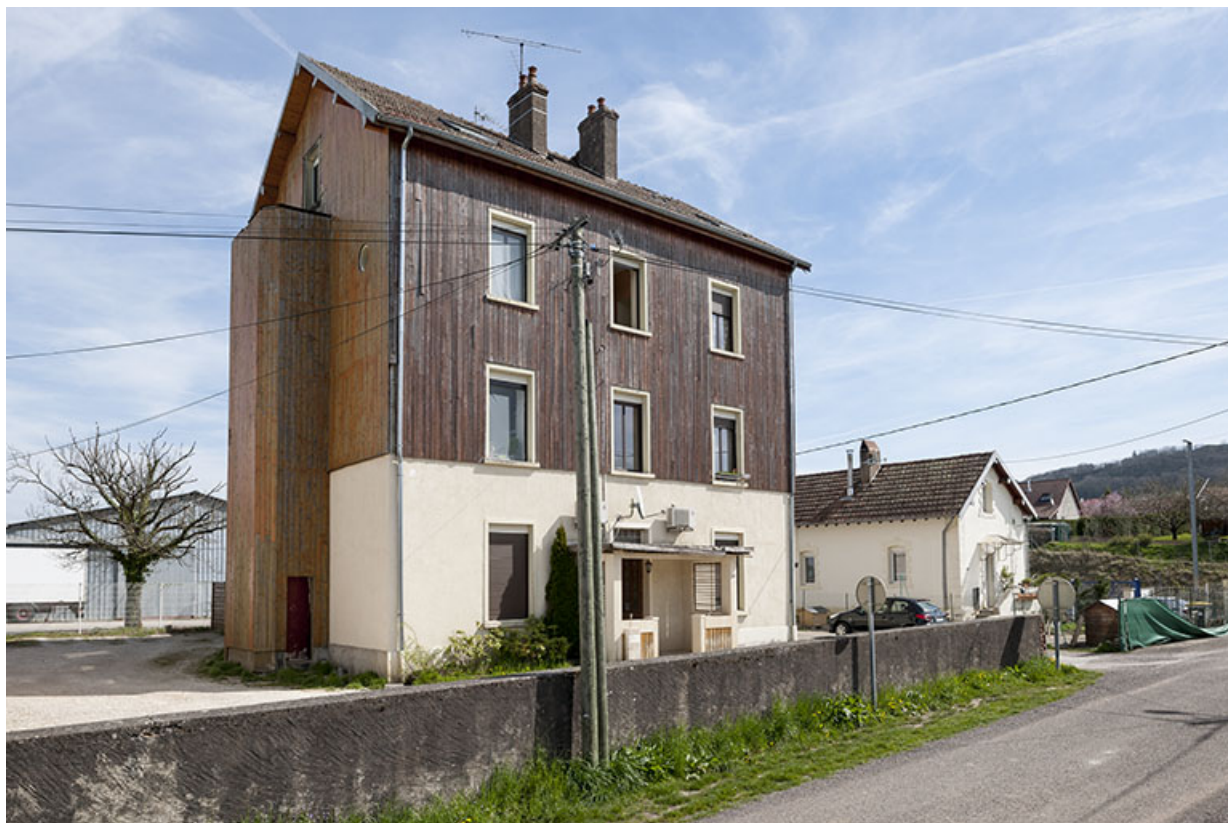
Ancien bâtiment de bureaux et logements.
