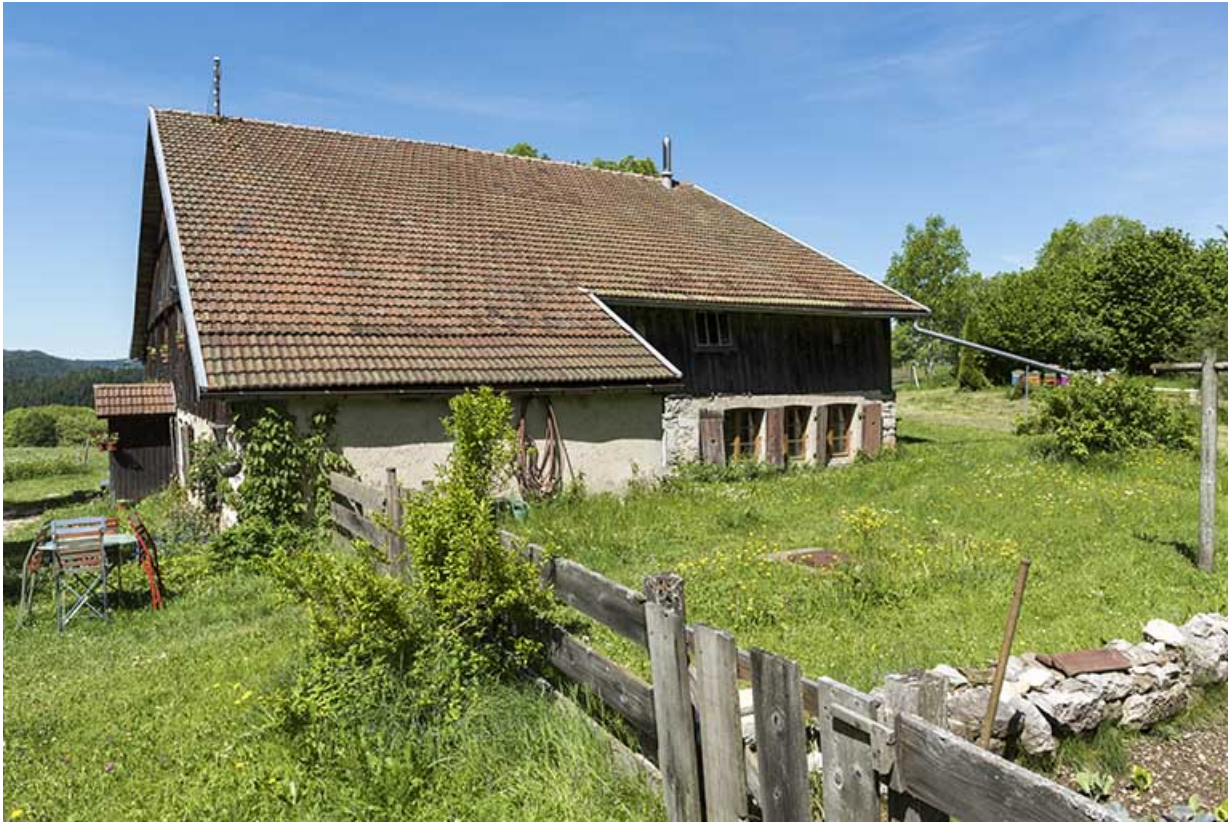
Façade latérale droite.
