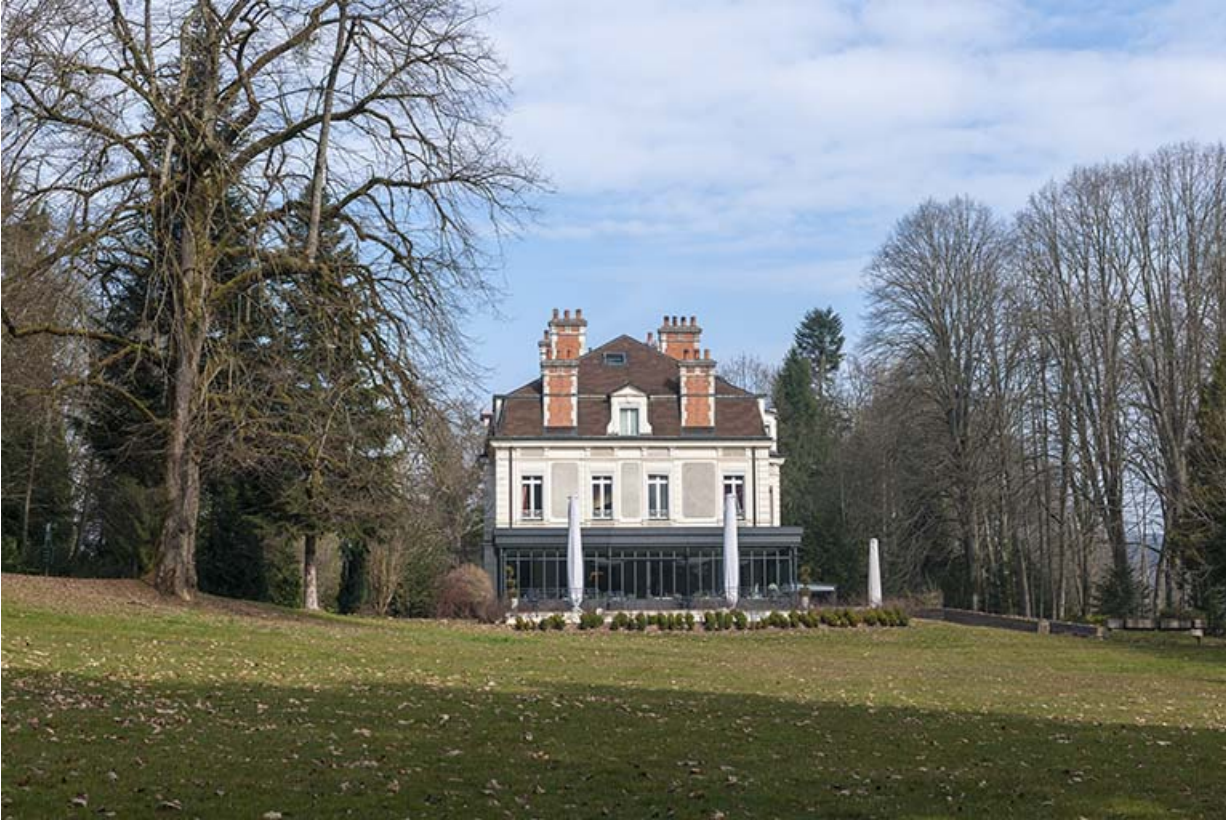
Logement patronal. Façade sud depuis le parc.
