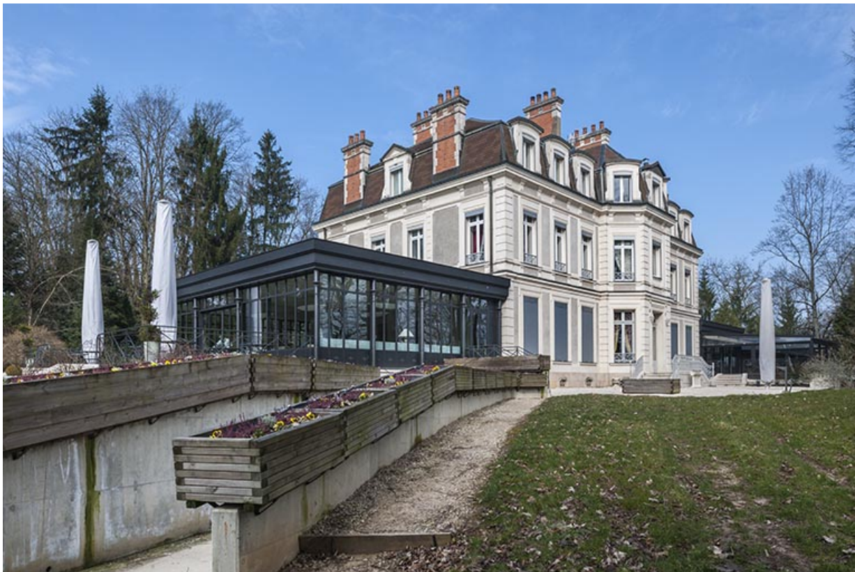
Logement patronal. Vue d'ensemble depuis le sud.
