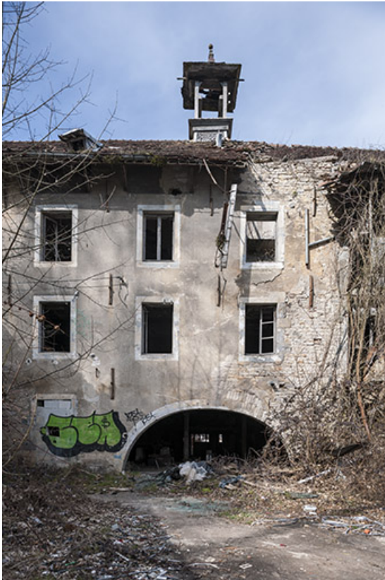
Façade sud de l'atelier principal.
