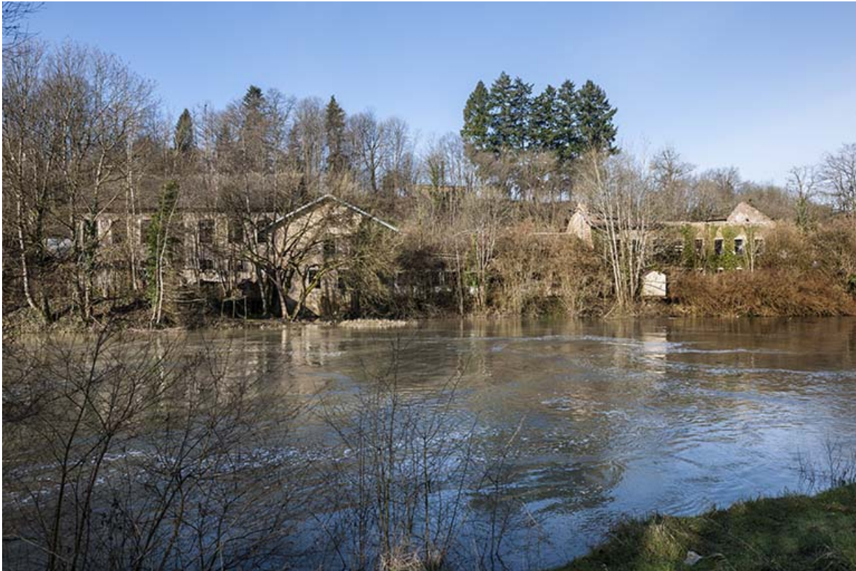
Vue d'ensemble depuis la rive droite.
