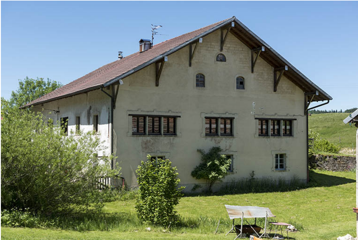
Façade latérale droite, de trois quarts gauche.
