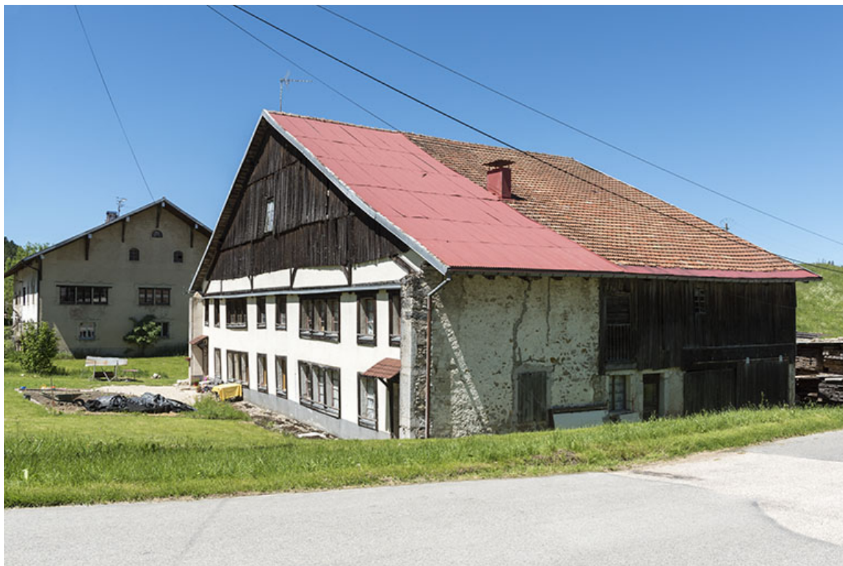
Façades antérieure et latérale droite.
