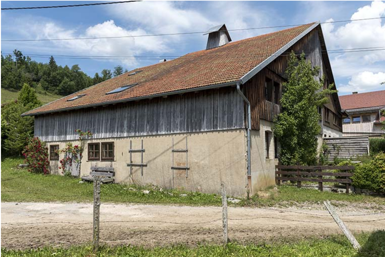
Façades antérieure et latérale gauche.
