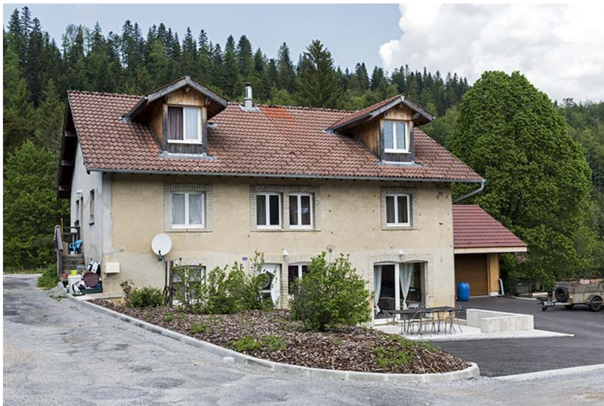
La maison : vue d'ensemble.
