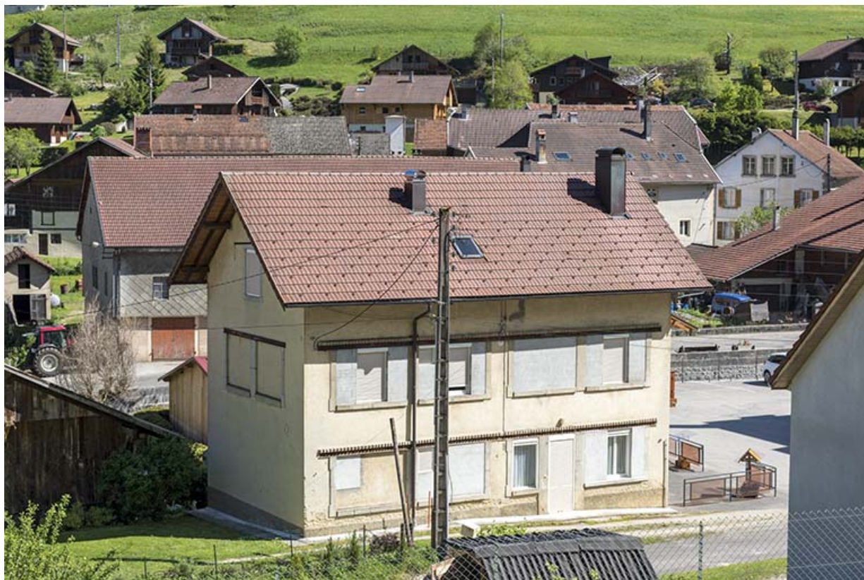
Façades postérieure et latérale gauche.
