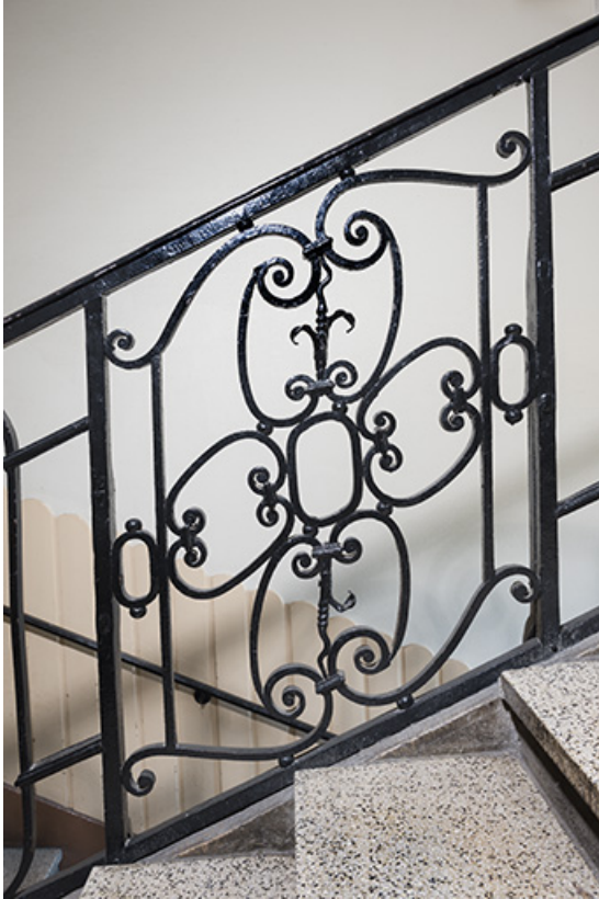
Grand escalier : motif central du garde-corps.
