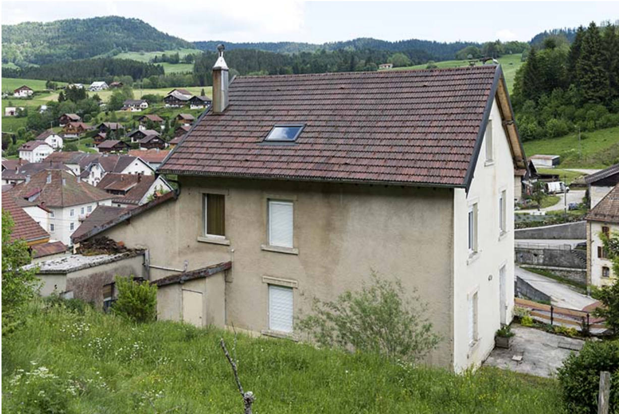
Façades postérieure et latérale gauche.
