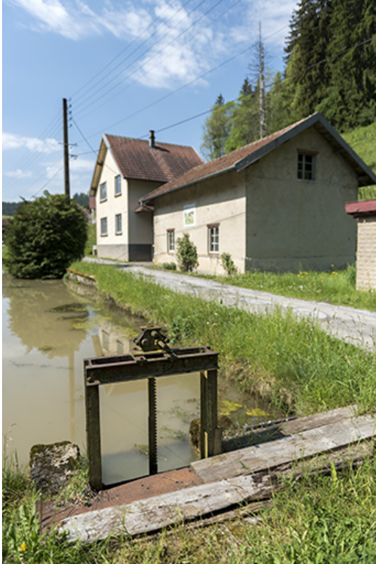
Vanne de prise d'eau, remise et maison.
