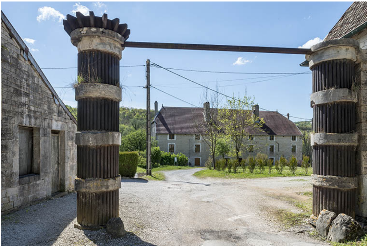
Portique d'entrée. Piliers fasciculés (pierre et fonte).
