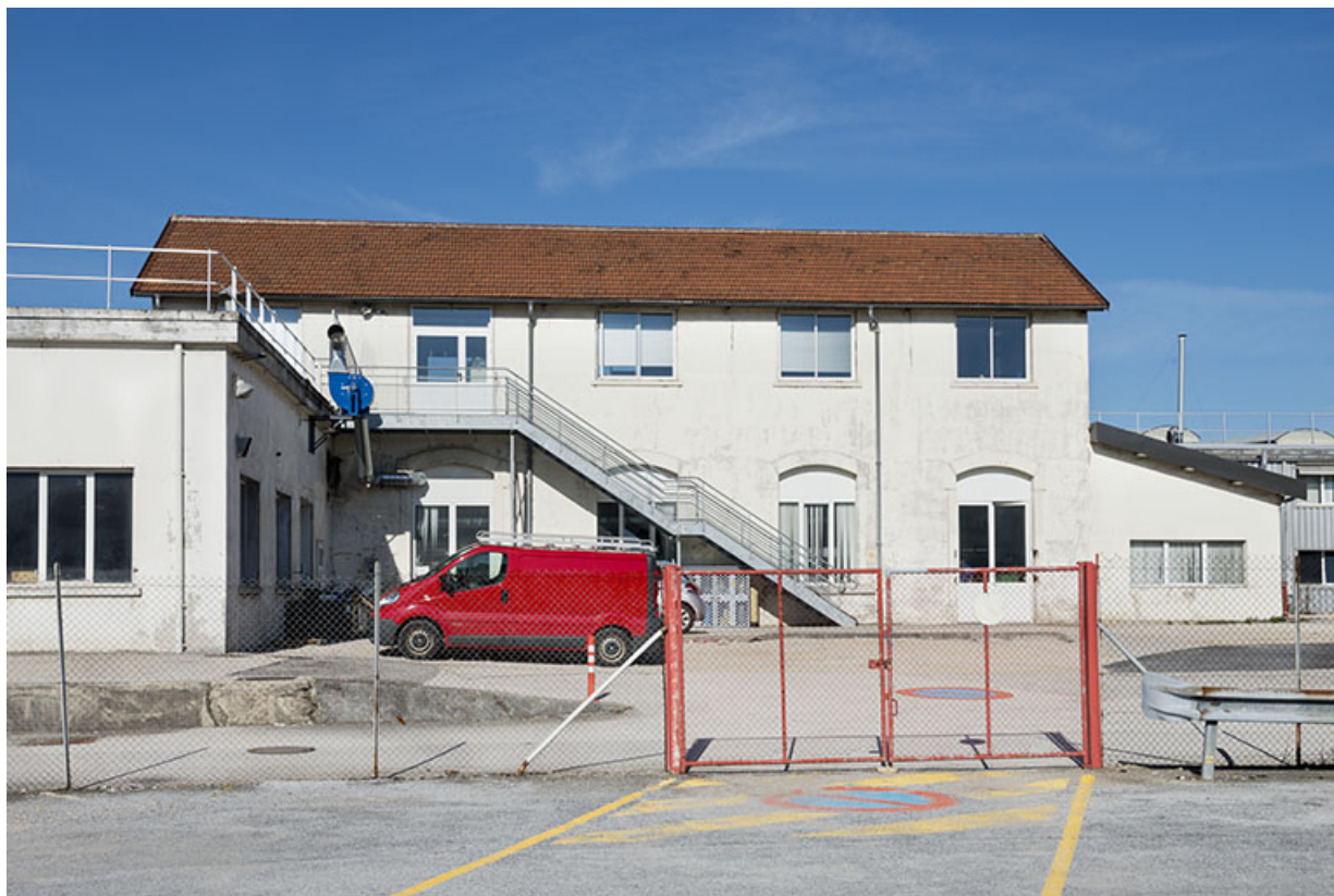
Atelier de mécanique (fonction originelle).
