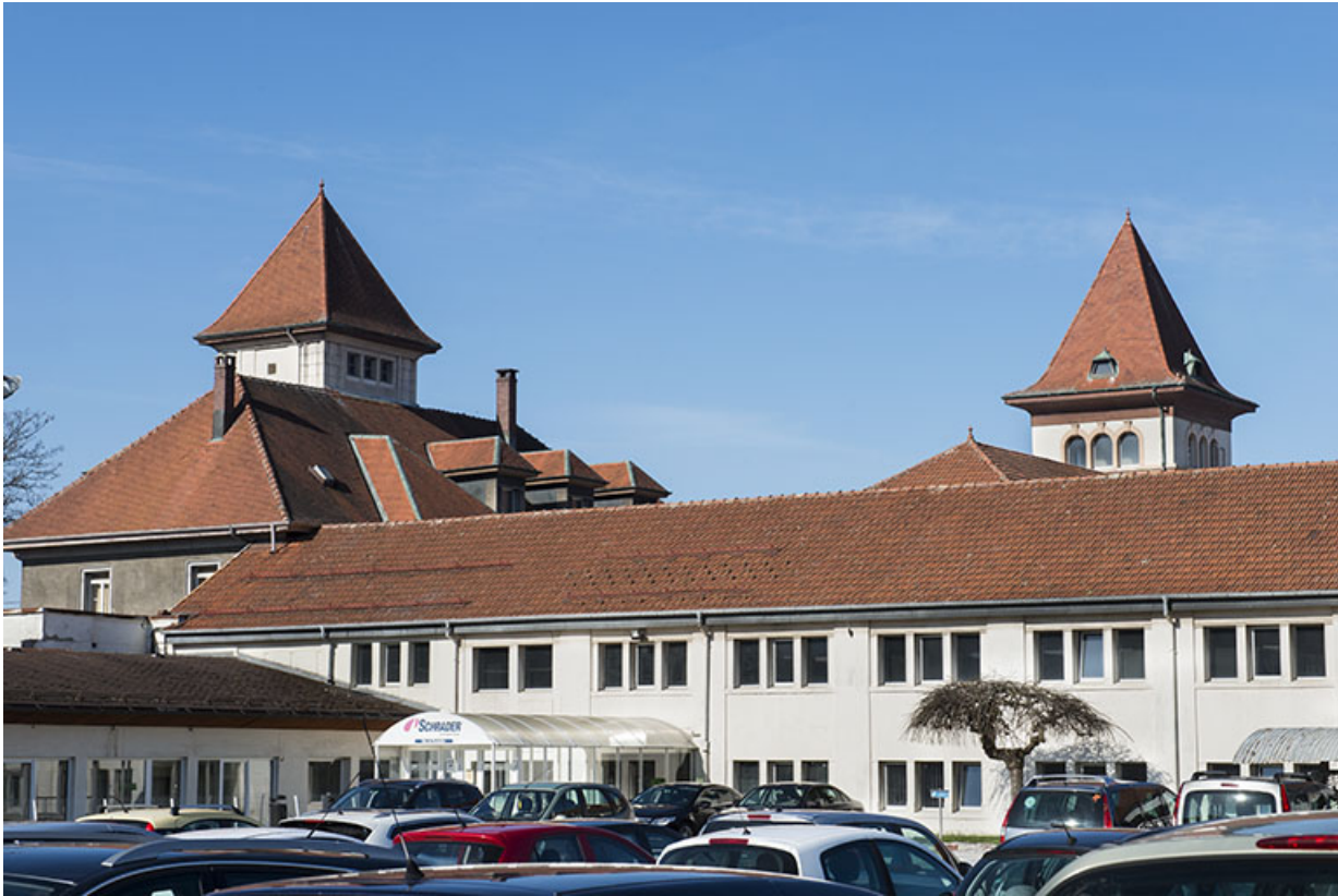
Bâtiments sud : conciergerie, bureaux, vestiaires.
