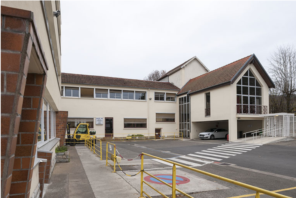
Bâtiments d'entrée (conciergerie et bureaux).
