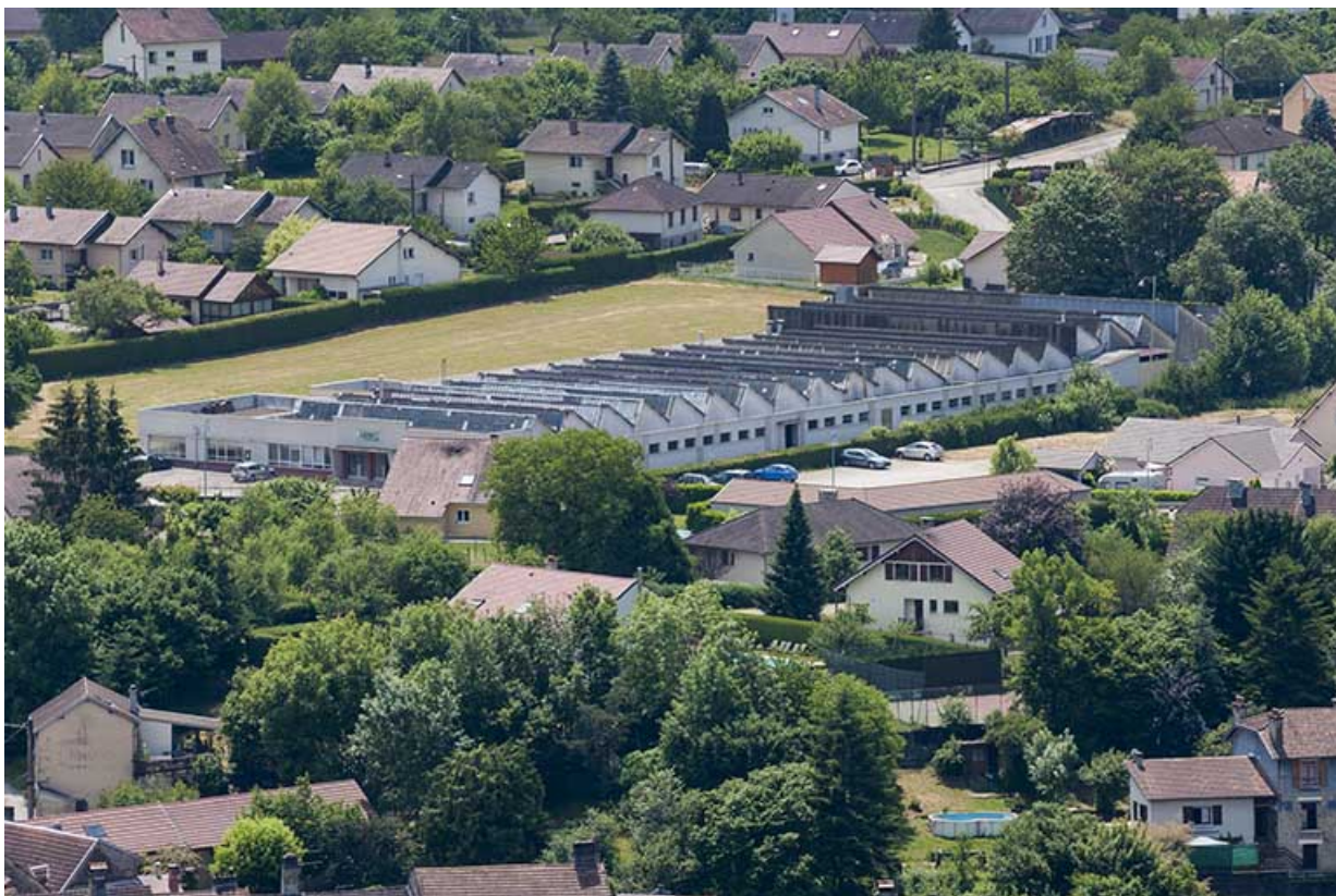
Vue plongeante depuis le nord-ouest.
