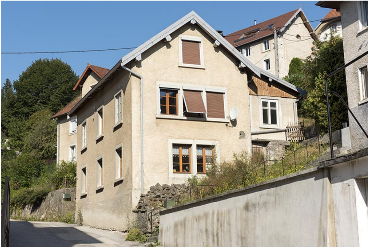
Façades antérieure et latérale droite.
