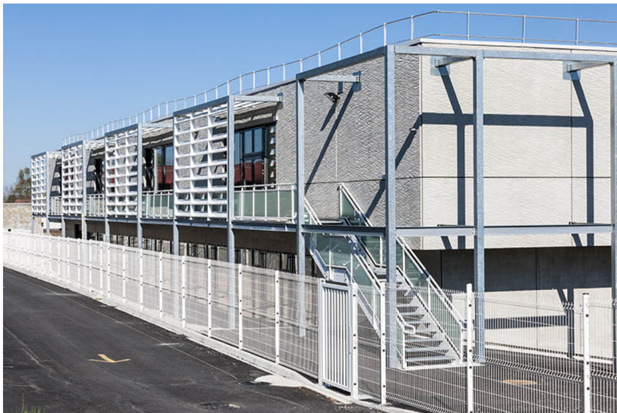
Façade sud de l'extension.
