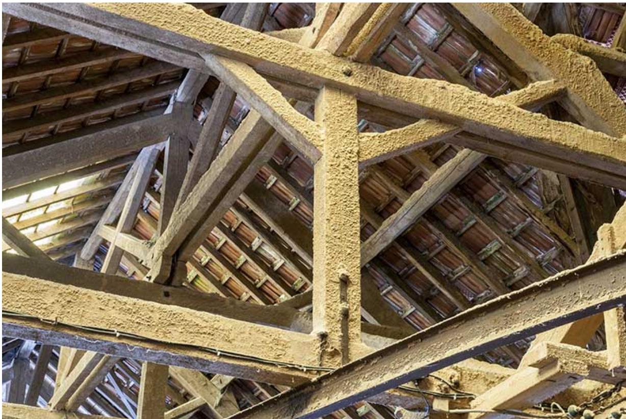
Détail de la charpente de l'atelier.
