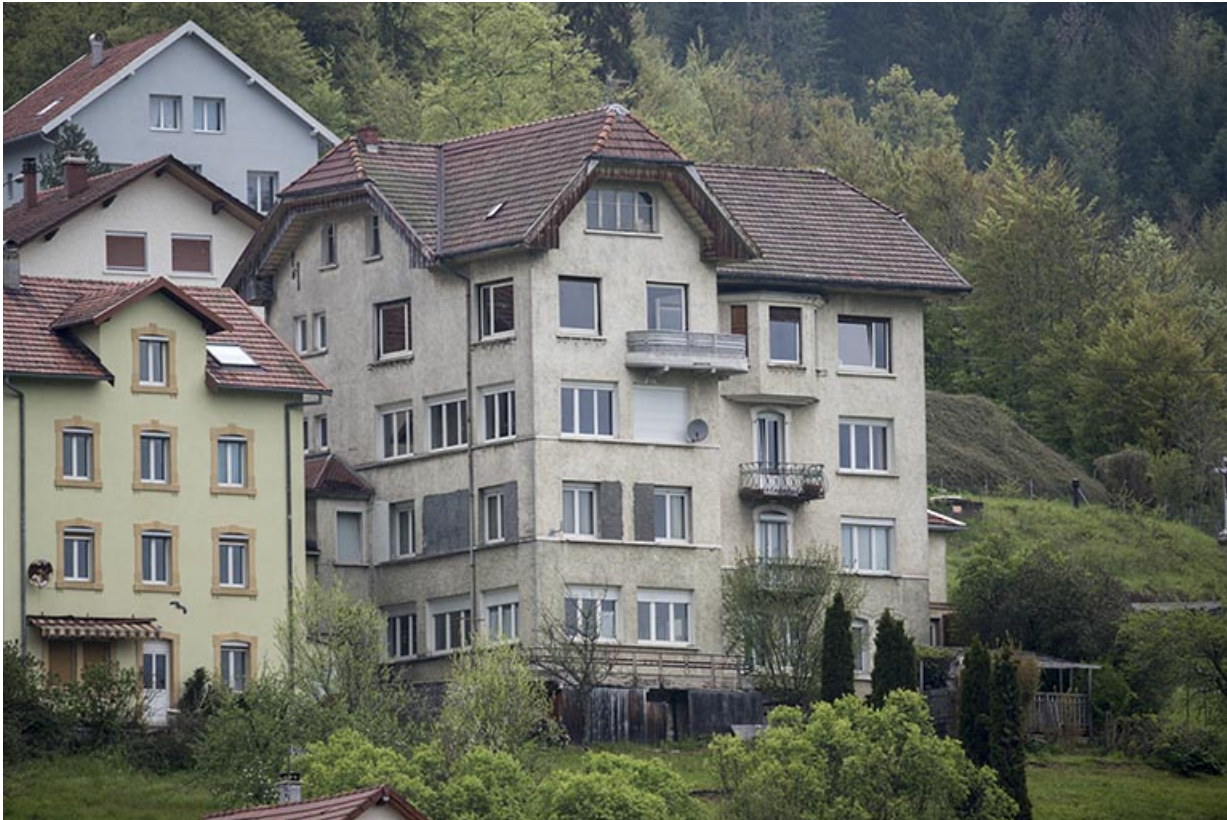
Façades postérieure et latérale droite.
