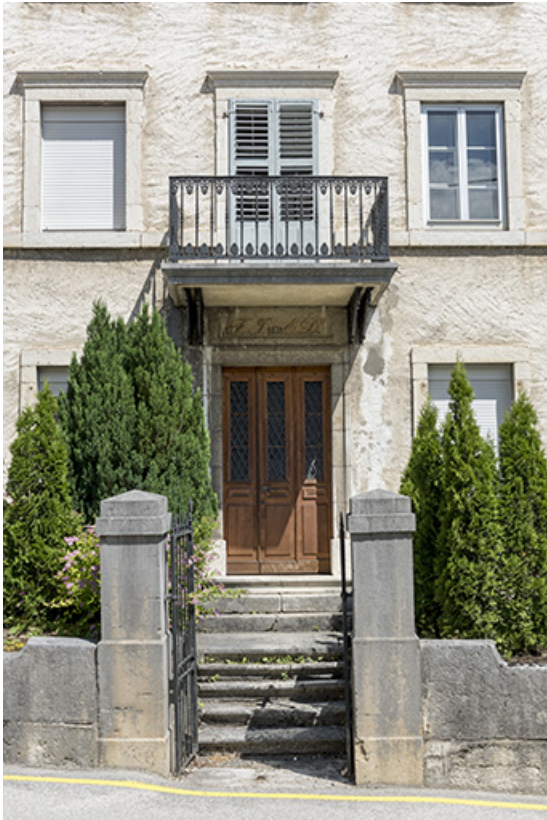
Façade antérieure : travée centrale.
