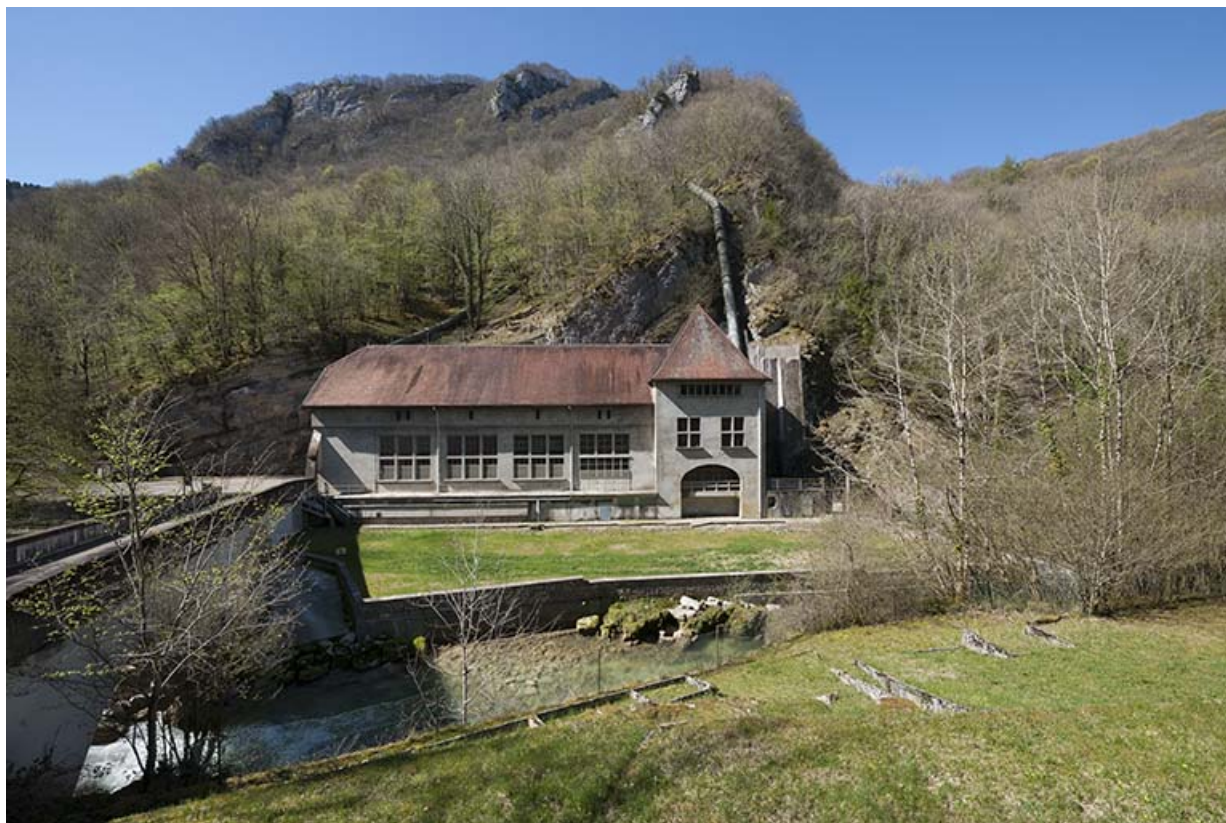
Façade antérieure de la centrale.
