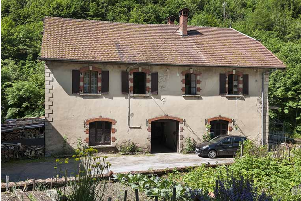
Atelier ouest (magasin et atelier de finissage)
