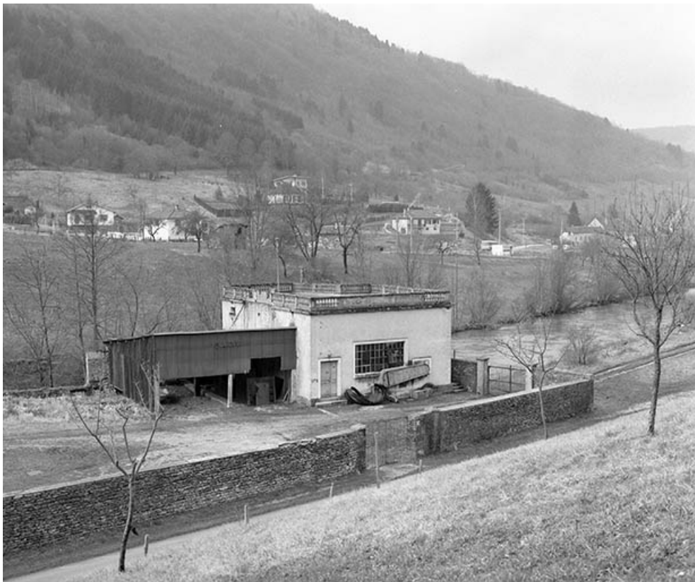
Le bâtiment d'eau de la tréfilerie Bersaillin.
