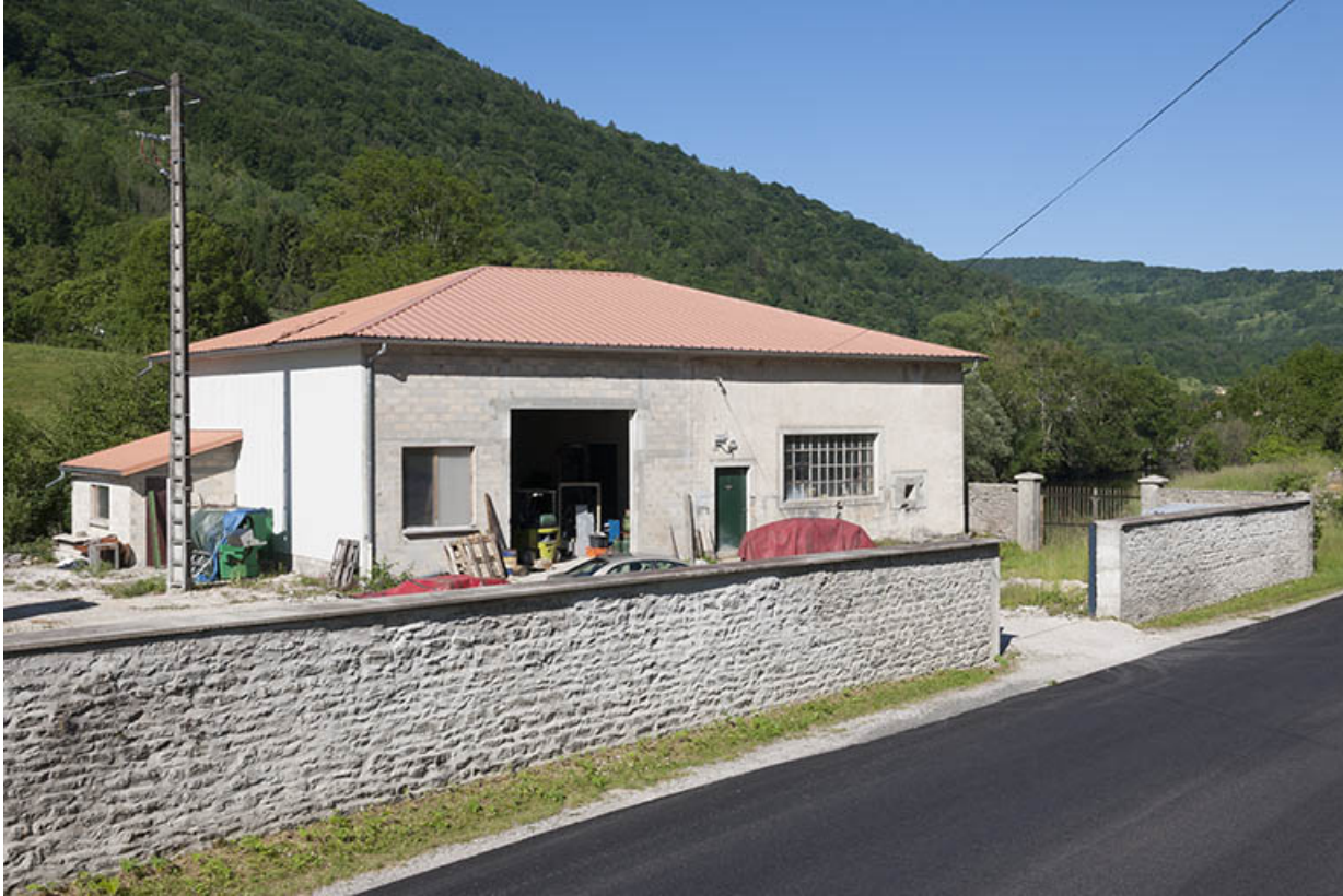
La centrale hydroélectrique.
