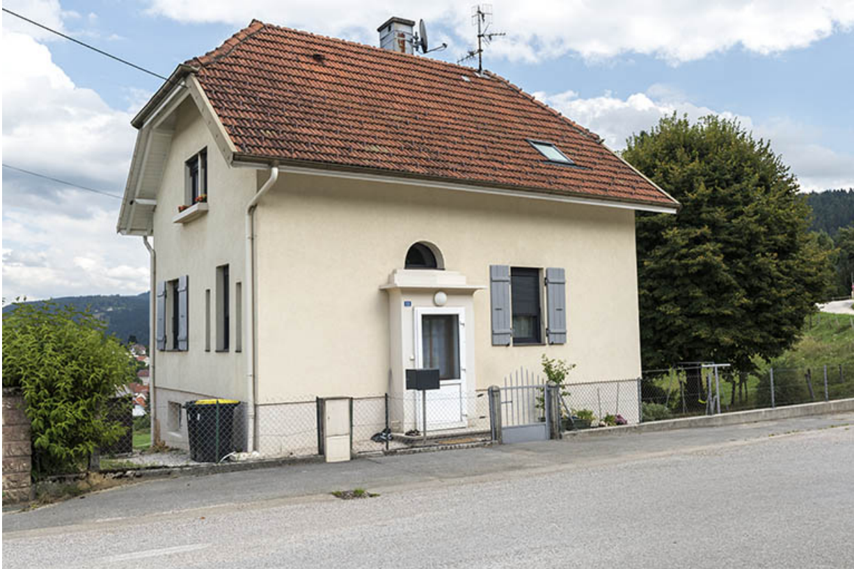
Façades antérieure et latérale gauche.
