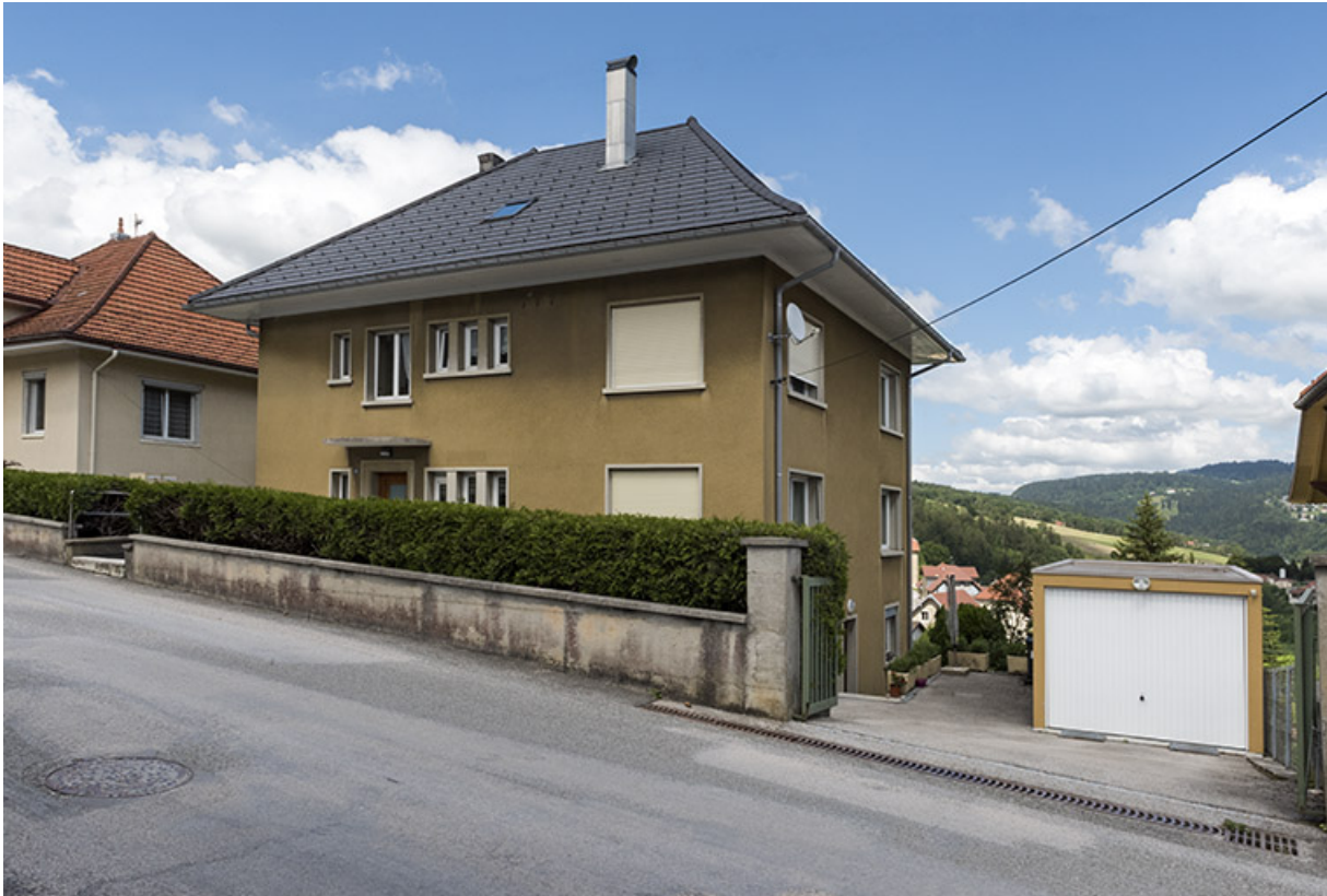
Façades antérieure et latérale droite.
