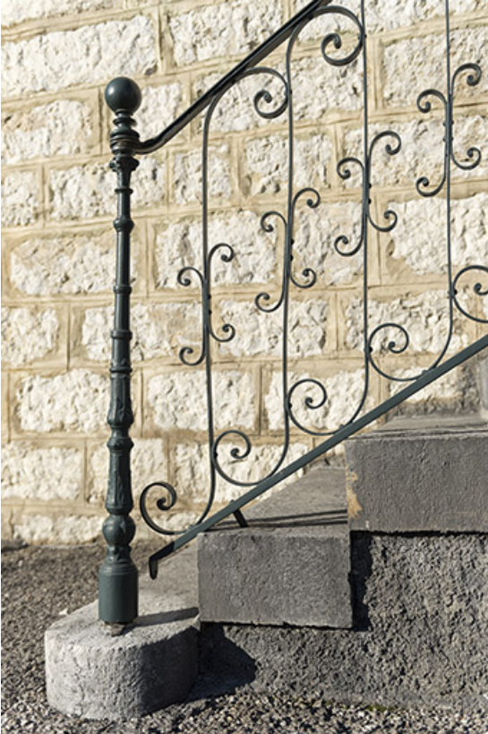
Façade antérieure : garde-corps de l'escalier.
