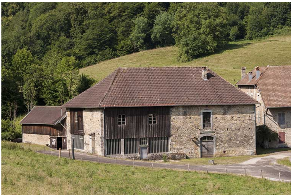
Façade nord de l'atelier de fabrication.
