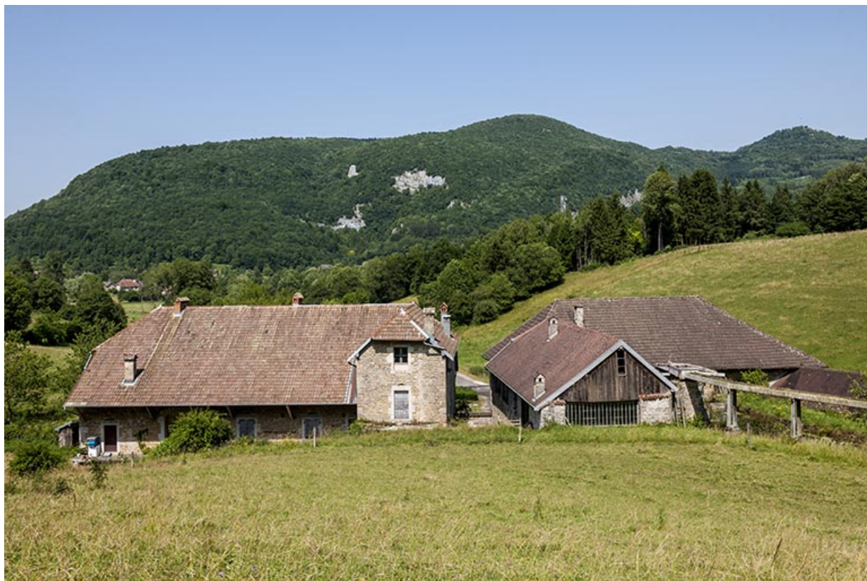
Façades sud des bâtiments.
