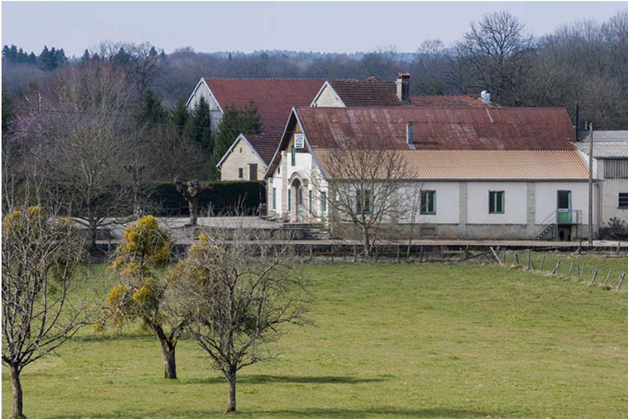
Façade nord de l'atelier de fabrication.
