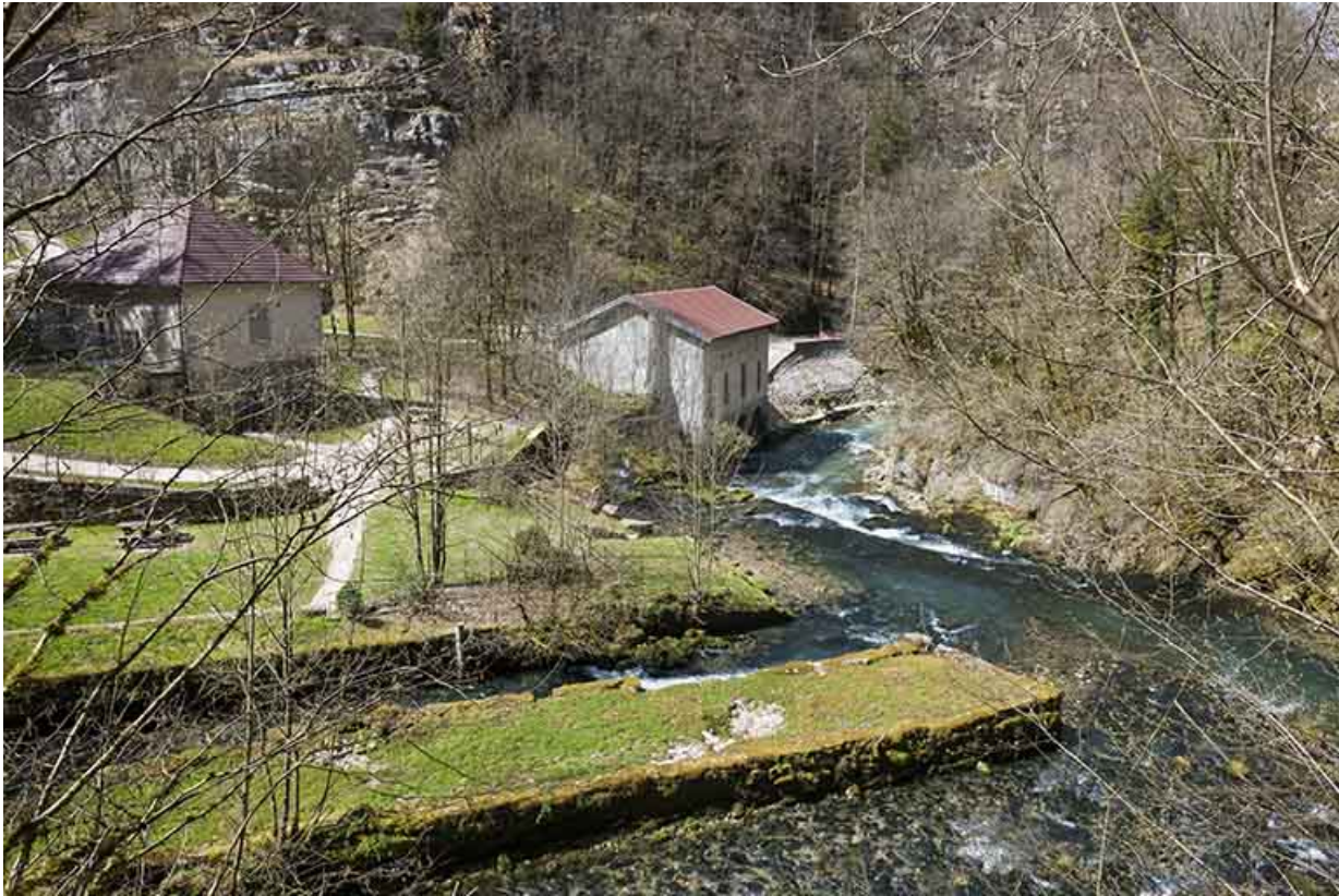
Vue d'ensemble depuis la source.
