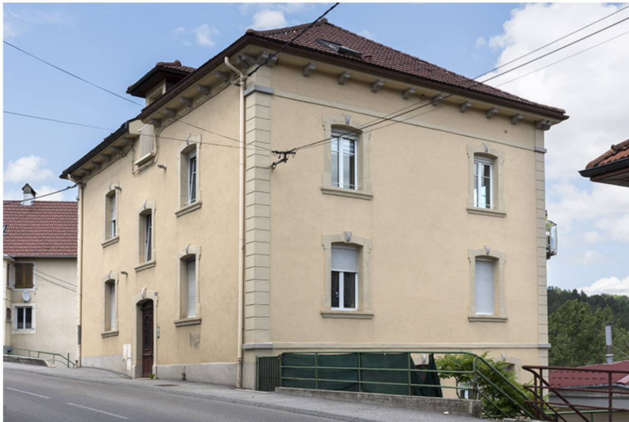
Façades antérieure et latérale droite.
