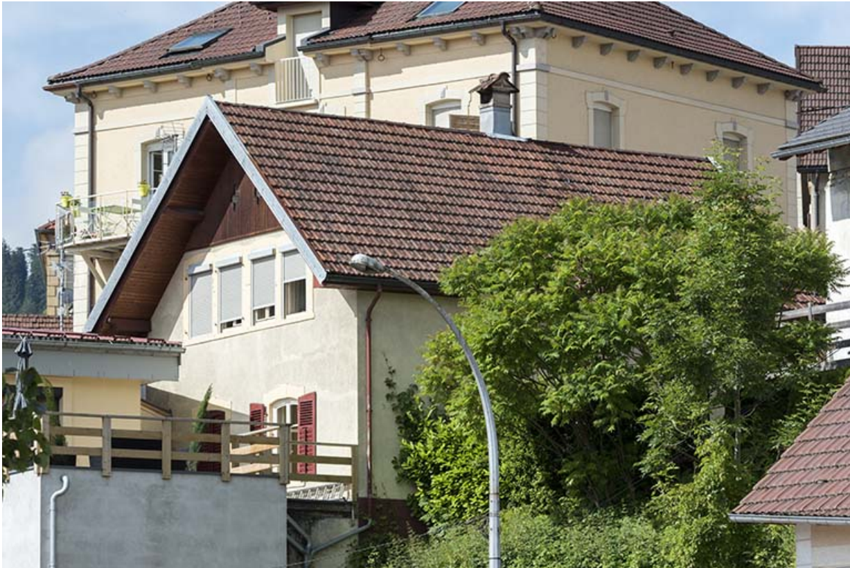
Façade latérale droite.
