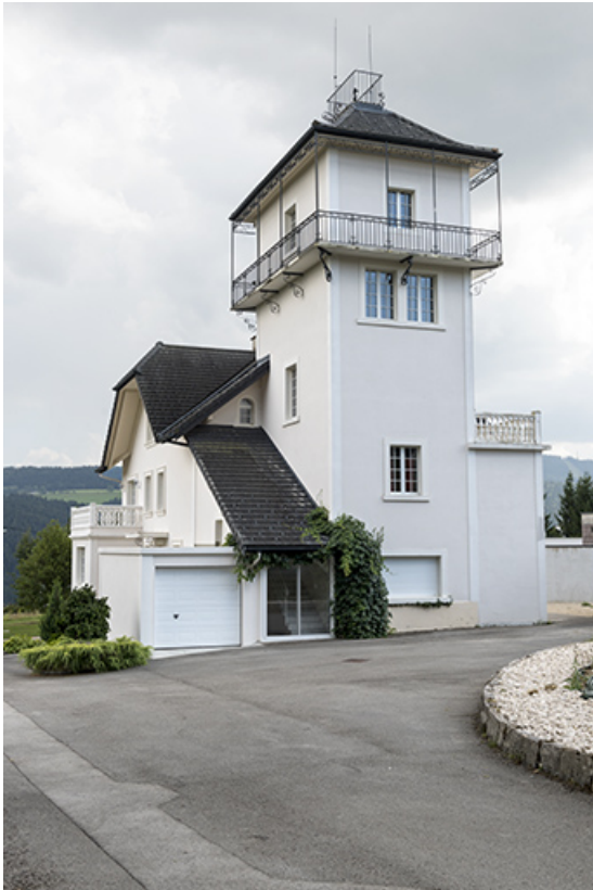
Façade latérale droite.
