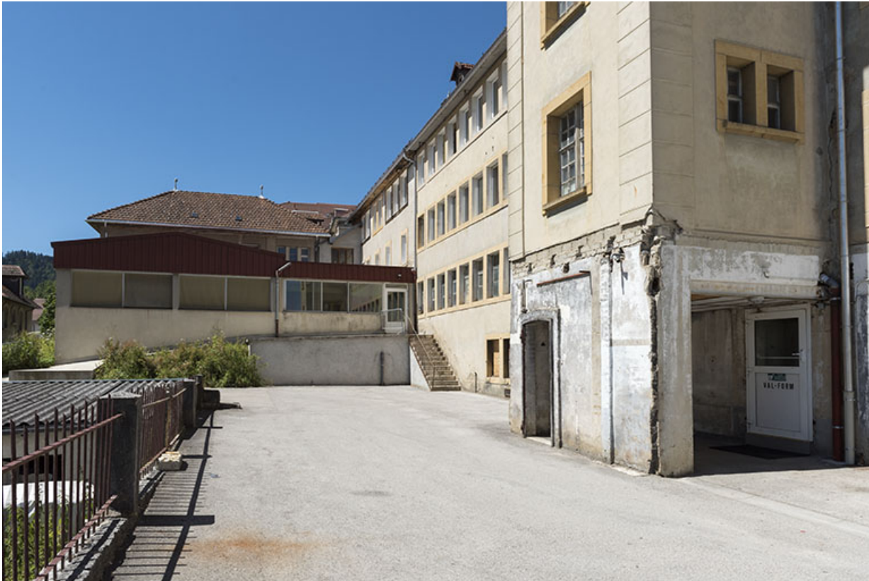
Usine : atelier de mécanique (façade latérale gauche).
