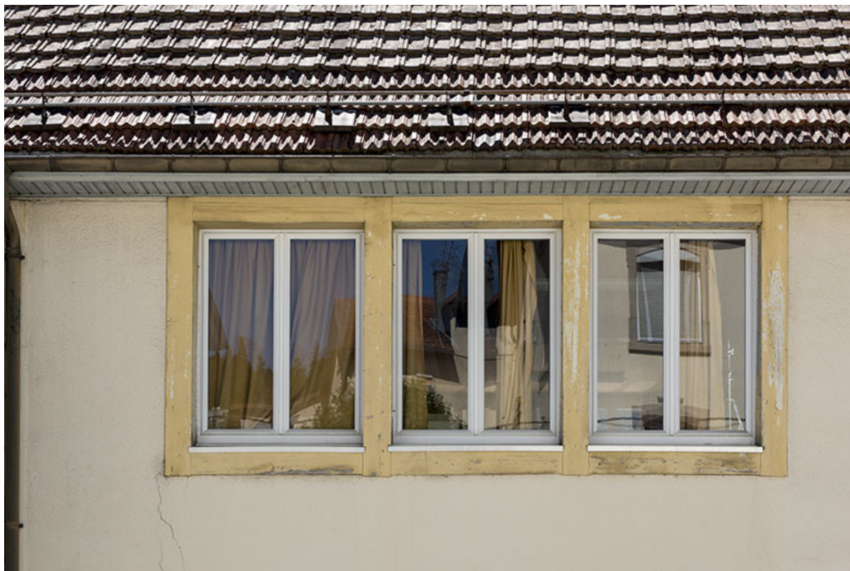
Bureau : fenêtres multiples sur la façade antérieure.
