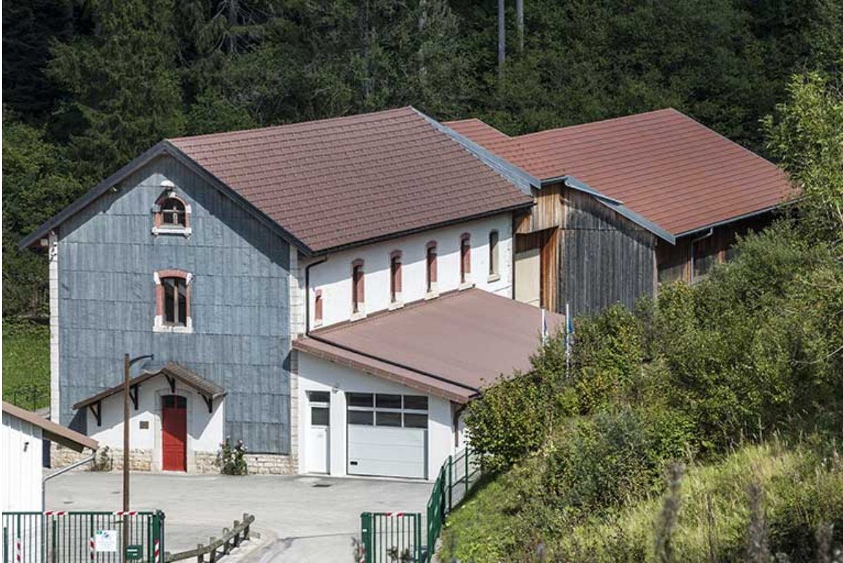
La centrale vue depuis le sud-ouest.
