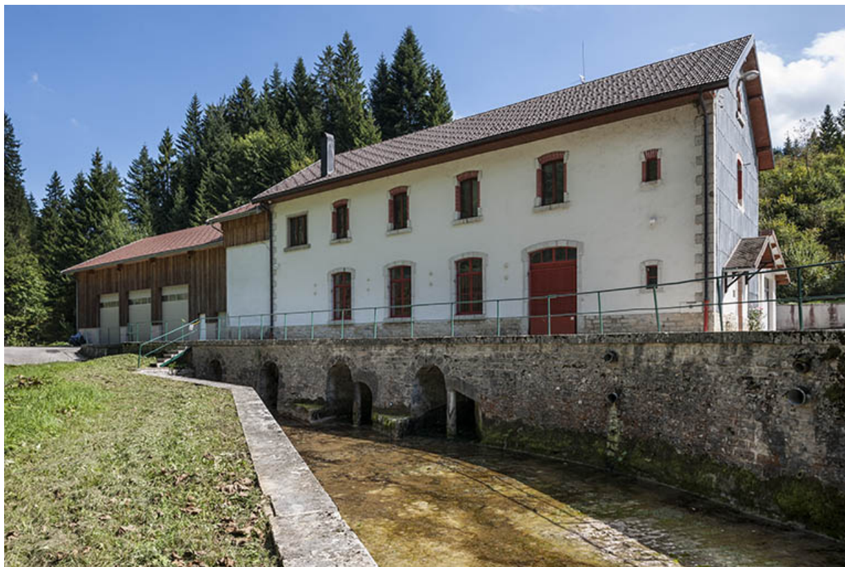
La centrale et le canal de fuite.
