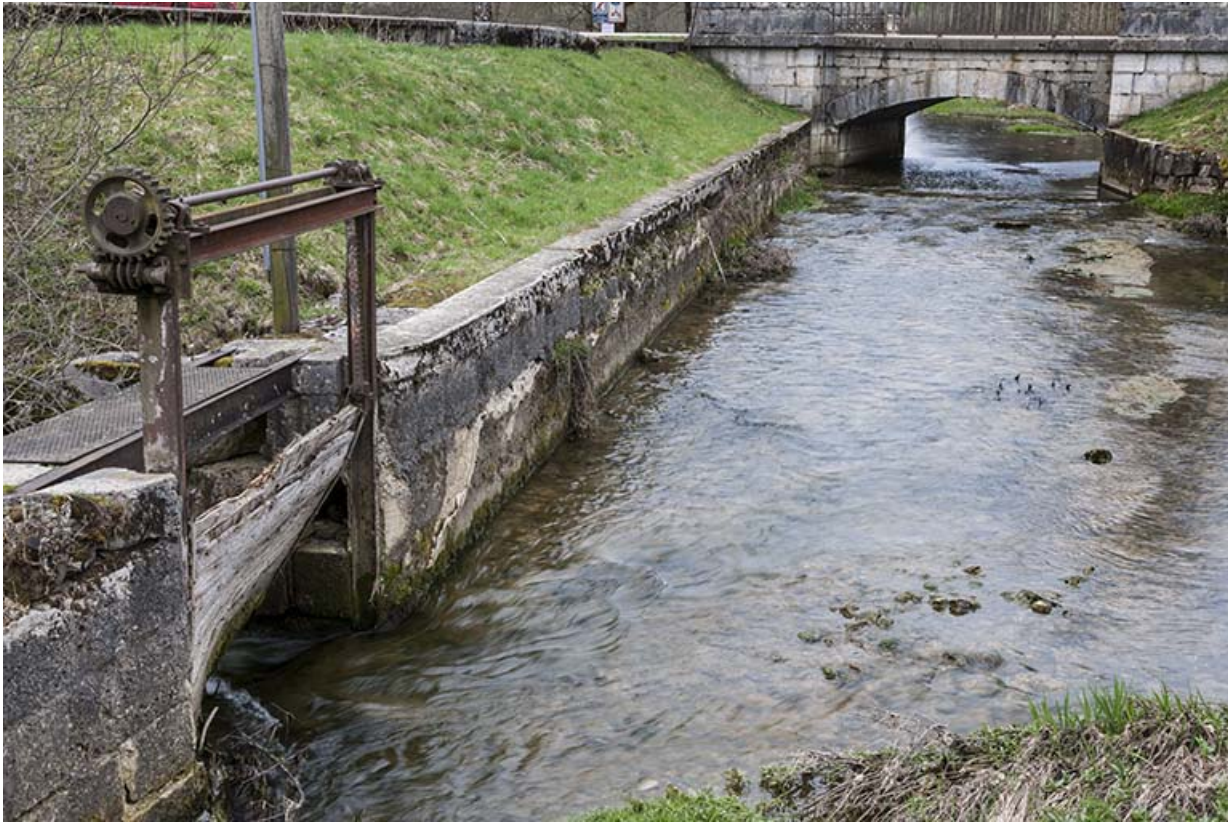
Canal d'amenée et vanne de décharge.
