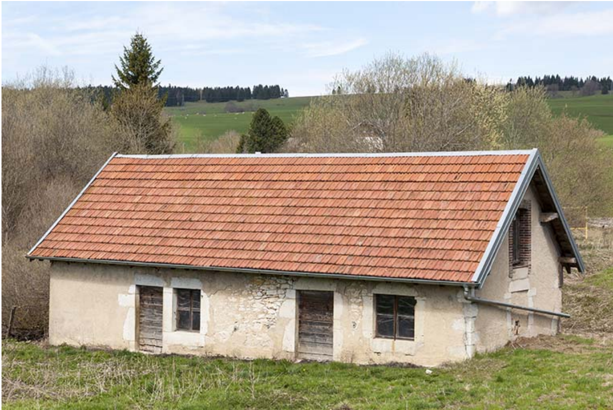
Ancien atelier de forge. Façade sud.
