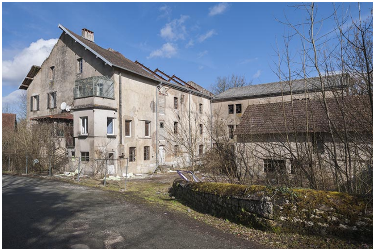
Vue d'ensemble depuis la rue du Canal.
