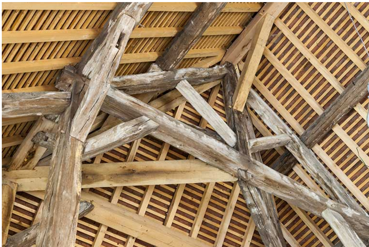
Détail de la charpente de la croupe.
