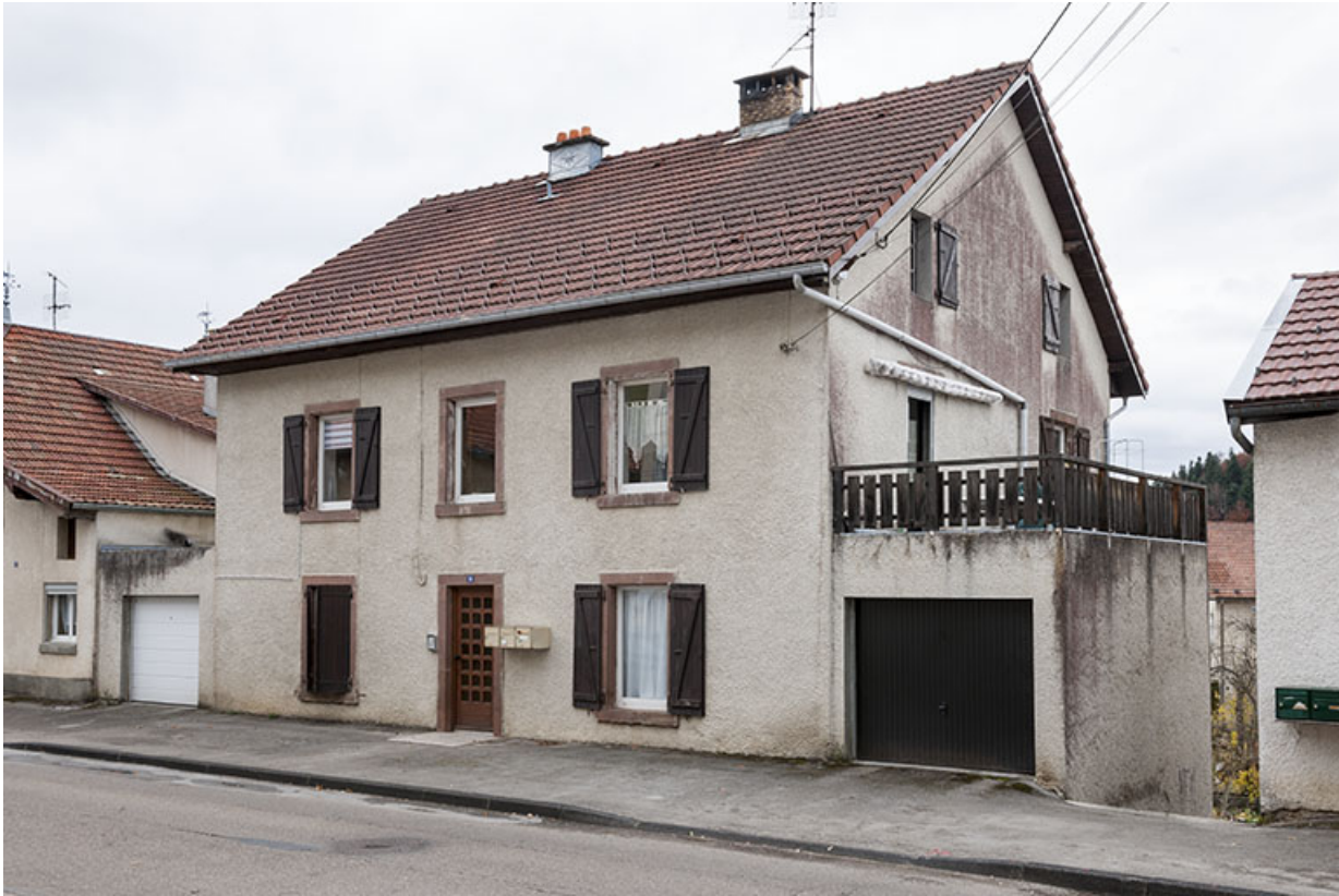
Façades antérieure et latérale droite.
