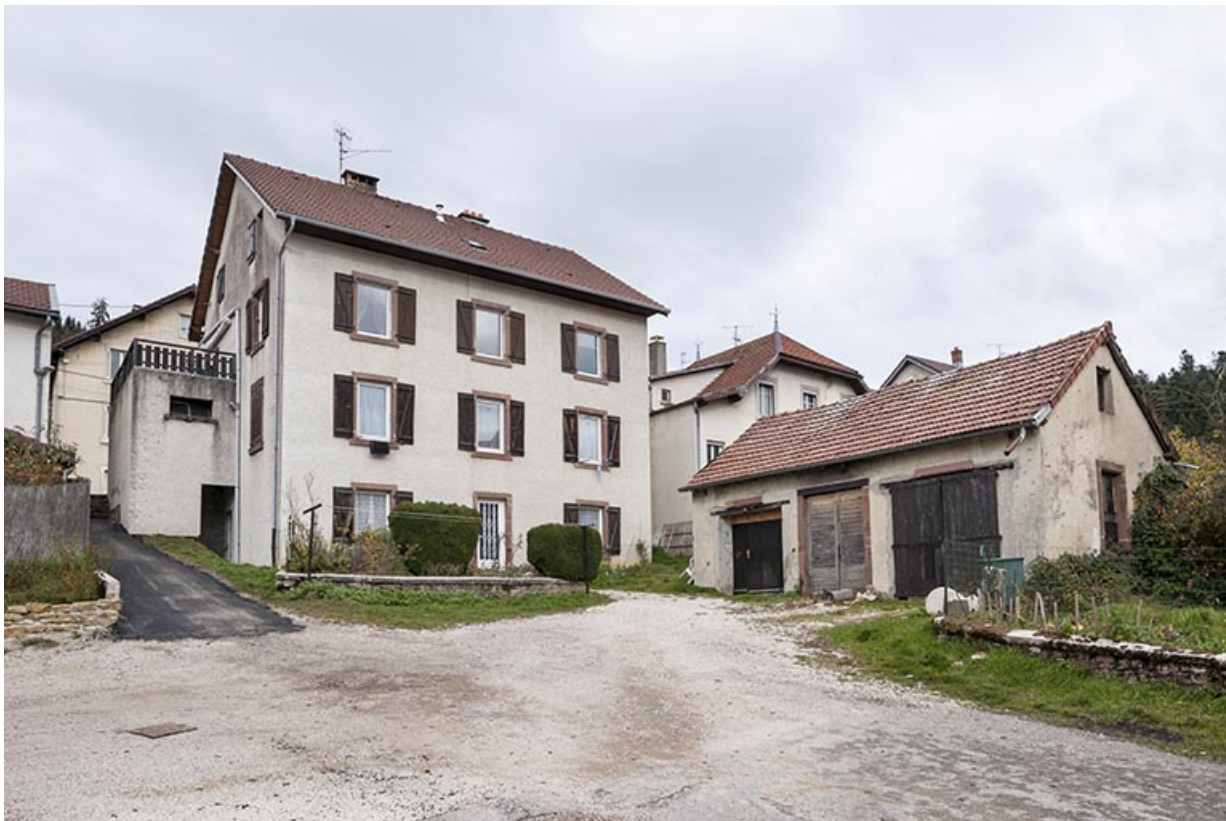
Façade postérieure et ancien atelier ou remise.
