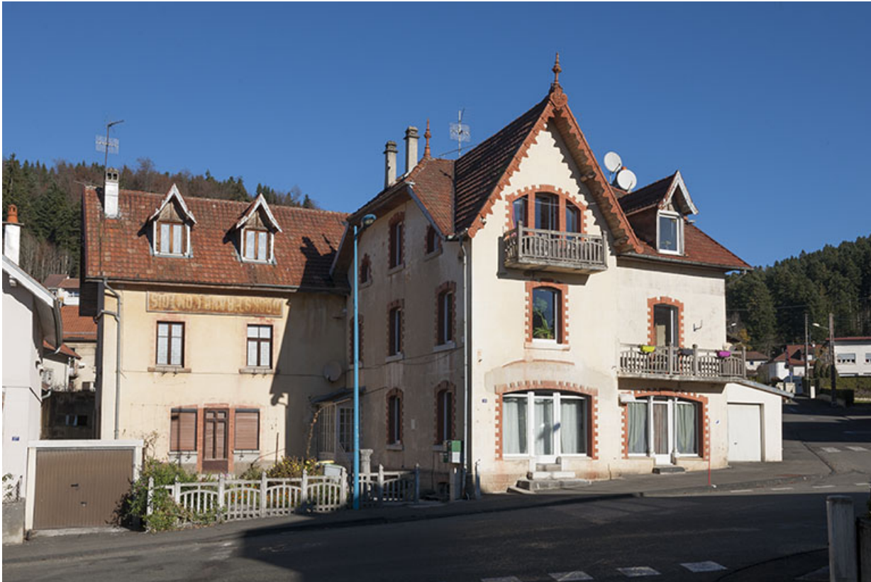
Façades antérieure et latérale gauche.
