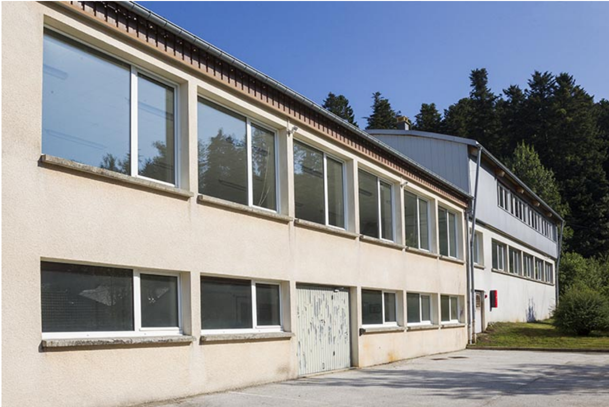
Façade latérale gauche, vue en enfilade.
