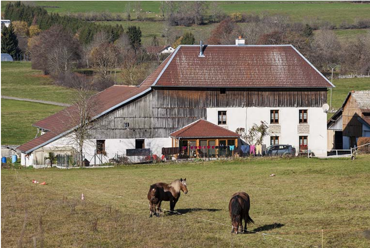
Ferme : façade sud.
