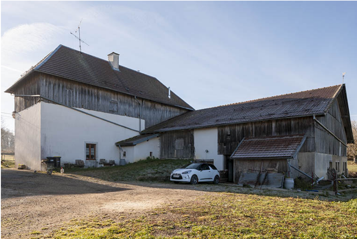
Ferme : façades nord et est.
