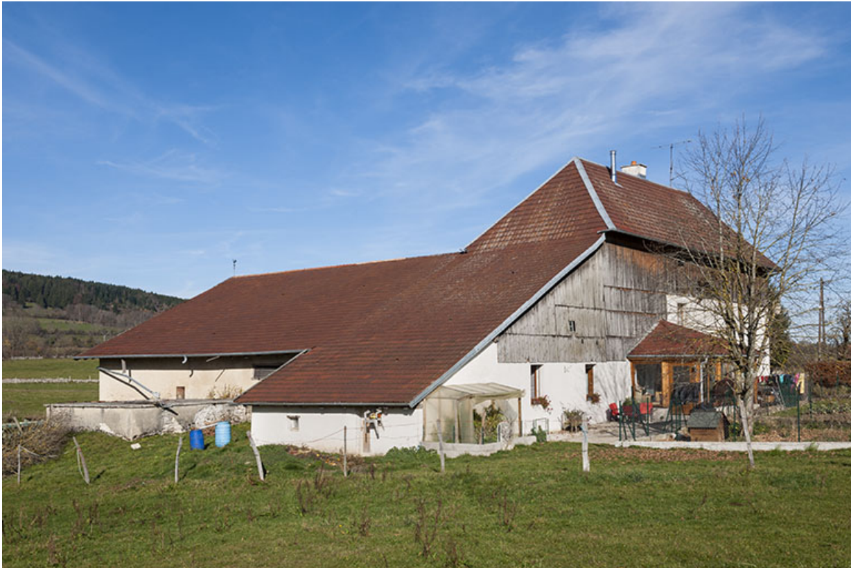
Ferme : façades sud et ouest.
