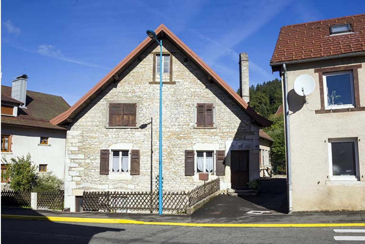
Maison : façade antérieure.
