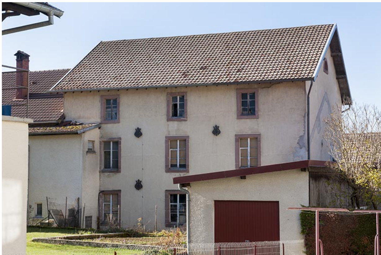
Minoterie : façade postérieure.
