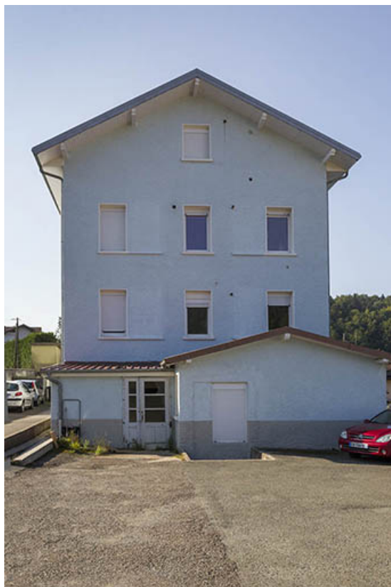
Façade latérale droite.
