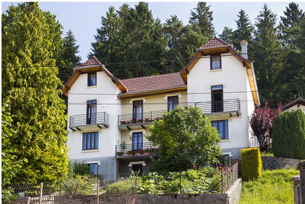
Immeuble n° 6 : façade côté vallée (ouest).
