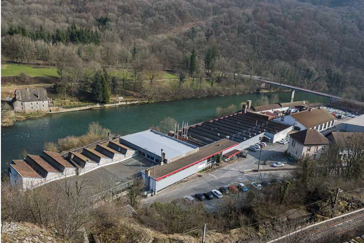
Vue plongeante depuis le nord-ouest.
